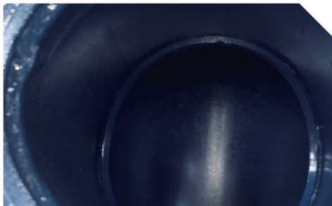
电泳管道内壁
