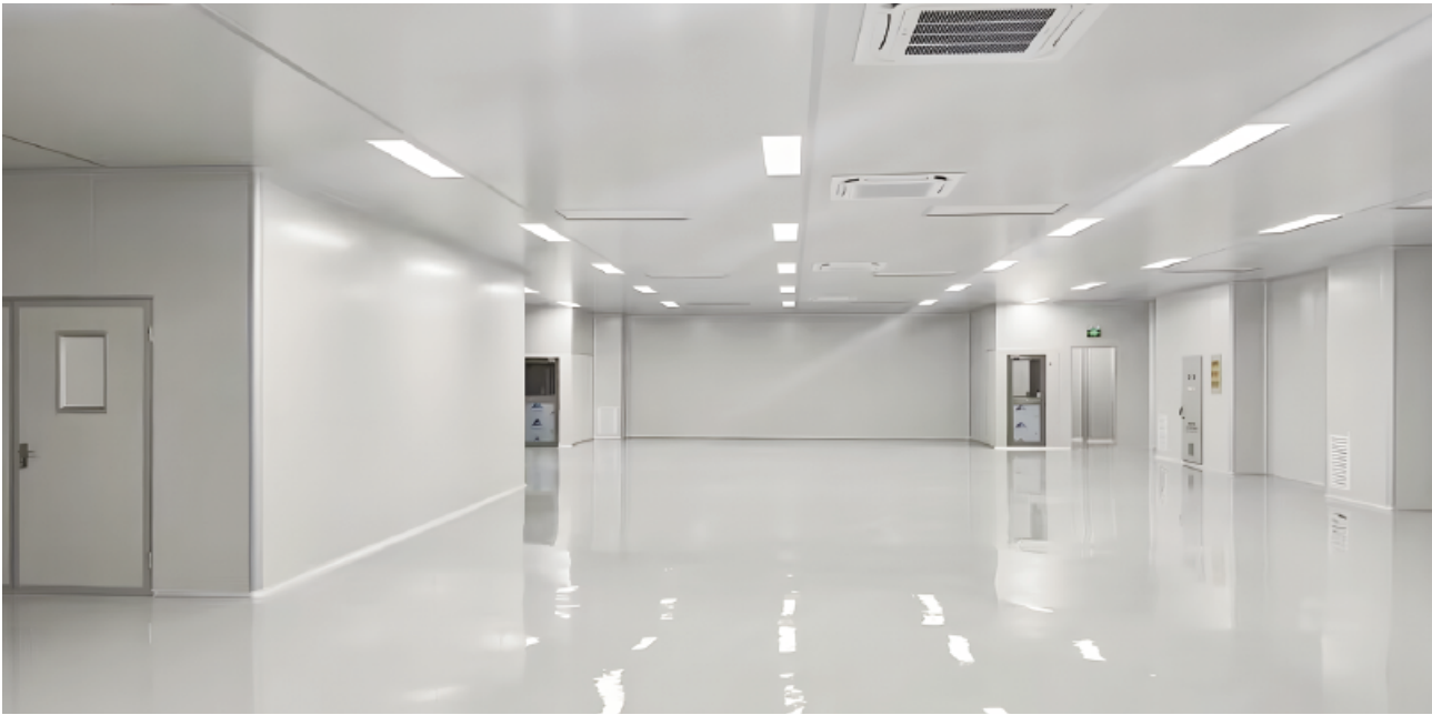
十万级无尘车间保障焊接作业环境
