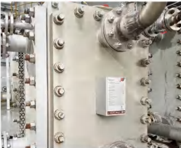
包头神华煤化工废水脱盐
